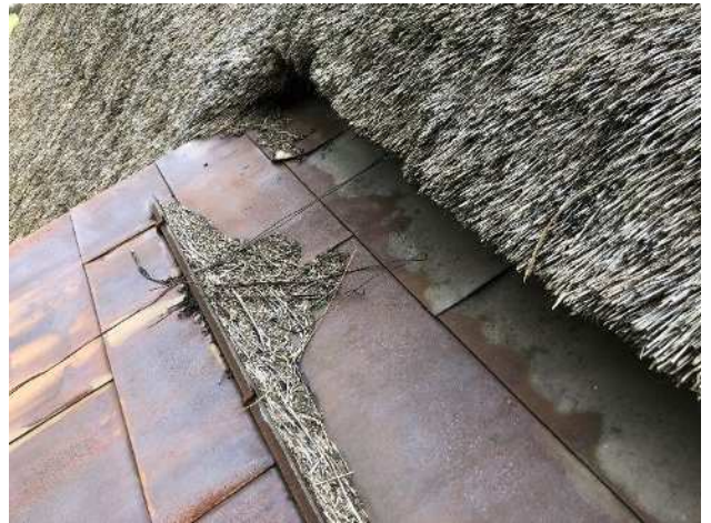
明かり窓庇屋根 近景
