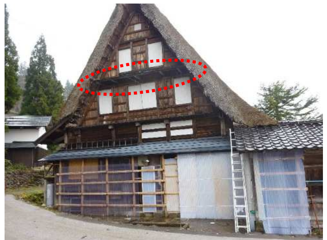
南側妻面窓庇屋根葺き板修理箇所
