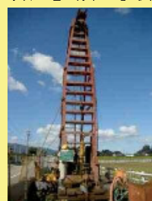
井戸さく井工事状況
