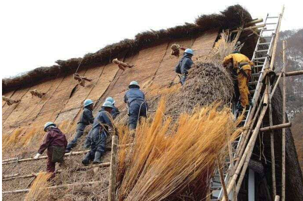
合掌造り家屋の茅葺き作業
