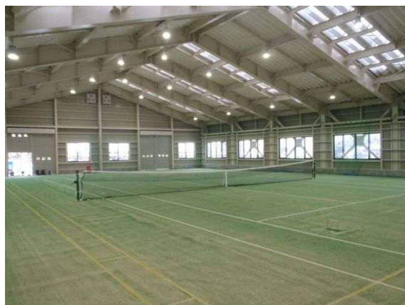
井口屋内グラウンド新築
