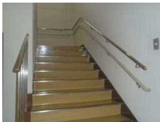
二重手すりの設置
