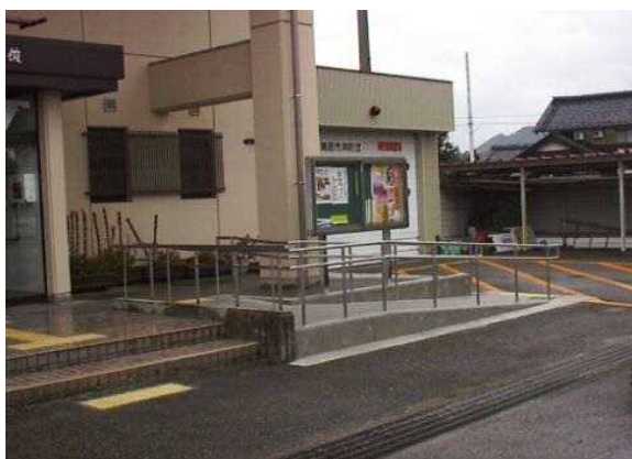
スロープの設置
