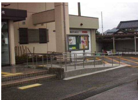
スロープの設置
