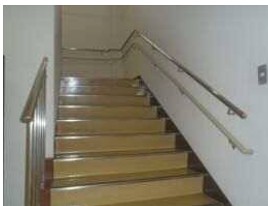
二重手すりの設置
