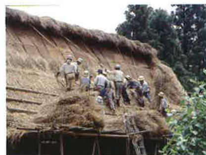
茅葺屋根の葺き替え
