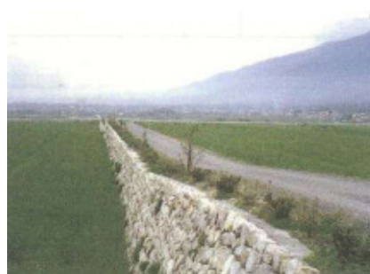
石積みで多孔質の空間を好む 生物に生息に配慮した（例）
