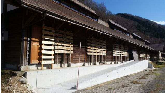
グルメ館スロープ手すり
