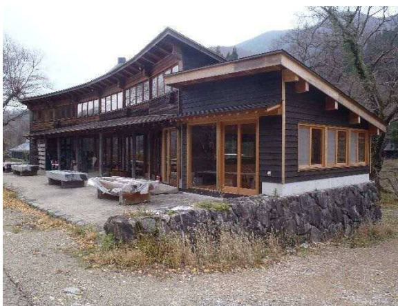
ボルカノテラス外装
