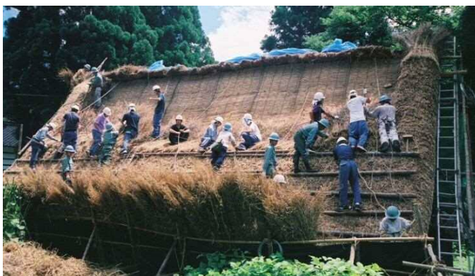
合掌造り家屋の茅葺き作業
