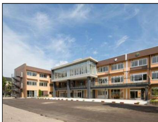
井波中学校 長寿命化改修
