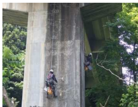
対象部材（従来技術；ロープ高所作業）
