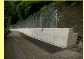
写真 祖山線 (落石防護柵)
