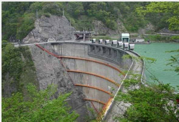
松村が尽力して完成した刀利ダム
