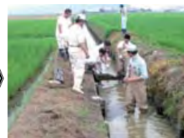
堰板撤去（6月下旬頃）
