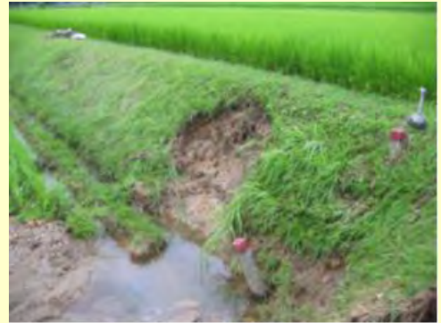
農用地法面が崩れた状況
