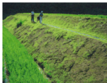
小段が設置されている法面
