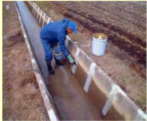
目地詰め作業
