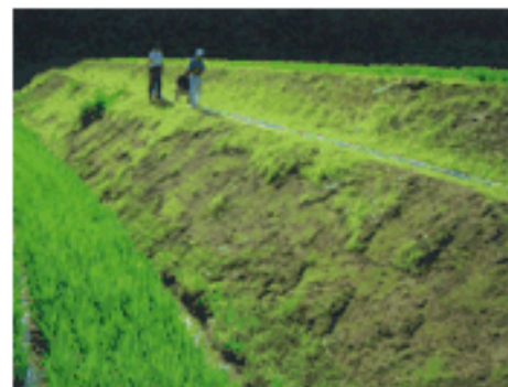
小段（犬走り）設置後の法面
