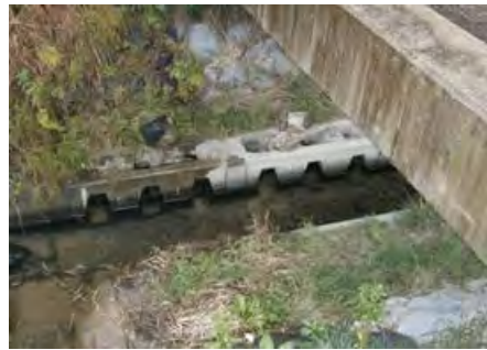
多孔コンクリート護岸
