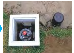
給水栓の自動化へ改良
