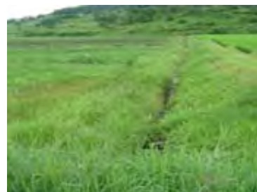
雑草の繁茂状況
