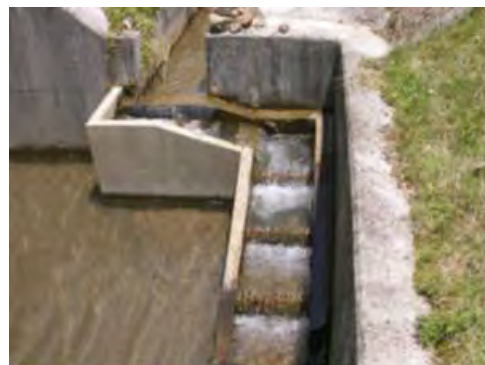
段差解消水路
