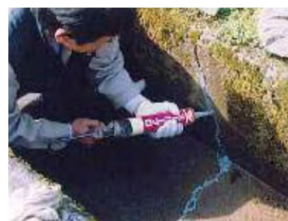
ひび割れ箇所へのシーリング材充填
