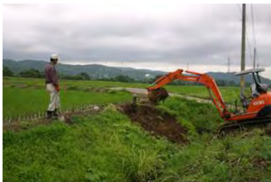
農用地法面の補修
