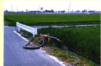
ポンプアップ状況
