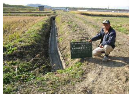
土側溝をコンクリート側溝に更新
