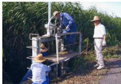
ゲートの点検
