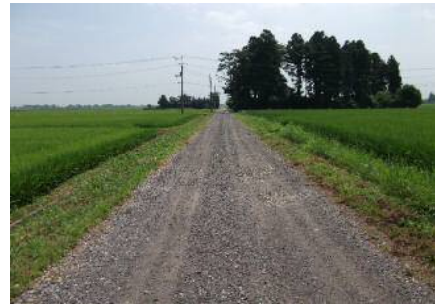
未舗装農道（砂利の路面）
