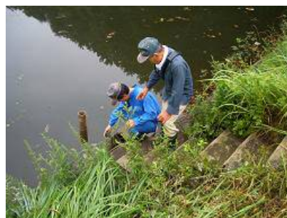
取水施設の点検
