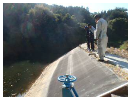
遮水シートの設置
