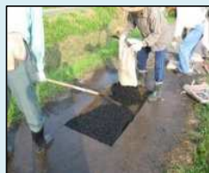
農道の部分補修
