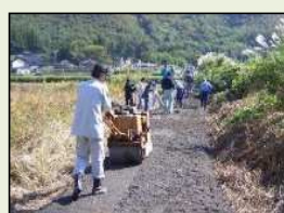
未舗装農道の舗装
