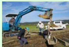
コンクリート水路の更新
