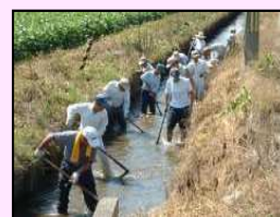
水路の泥上げ
