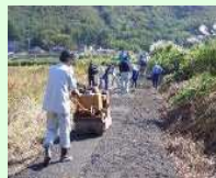
未舗装農道の舗装
