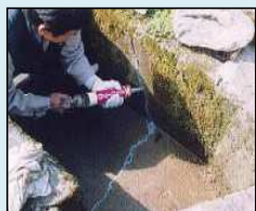
ひび割れの補修
