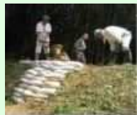
漏水箇所の補修
