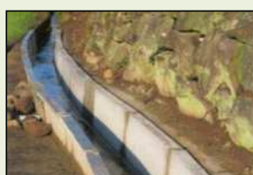
素堀り水路からの更新
