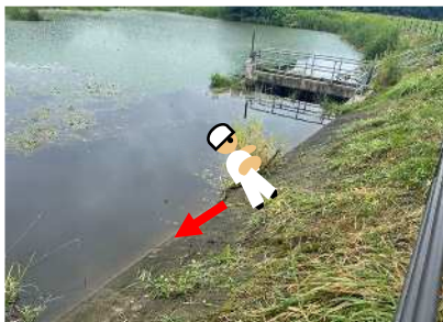
(ため池堤体の急傾斜)
