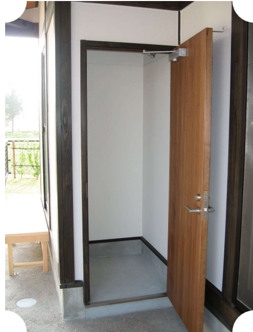
・各住戸に隣接する外部物置
