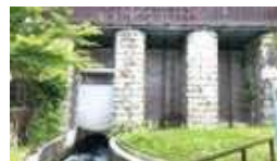
▲手取川七ヶ用水施設 (大水門)
