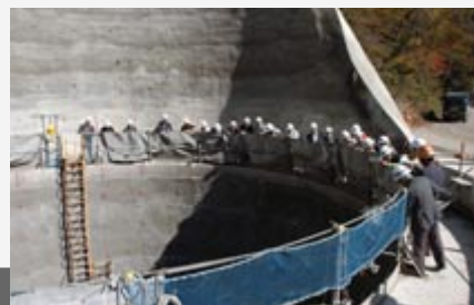
利賀ダム建設現場見学
