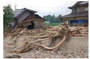
太谷川の氾濫で流れ着いた 流木と全壊した納屋 (福光地域才川七地区)
