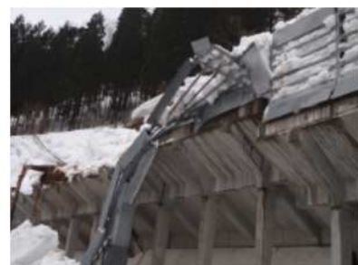
▲雪崩で被災した落雪防護柵
