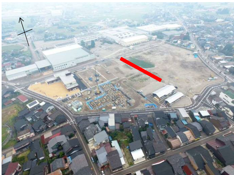
H29施工 市道中横町二日町2号線
